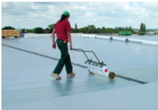
1 pav. Poliuretano klijų dengimas, naudojant aplikatorių
