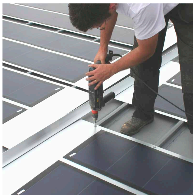
Skydų keitimas be rizikos pažeisti stogo dangos membraną.
